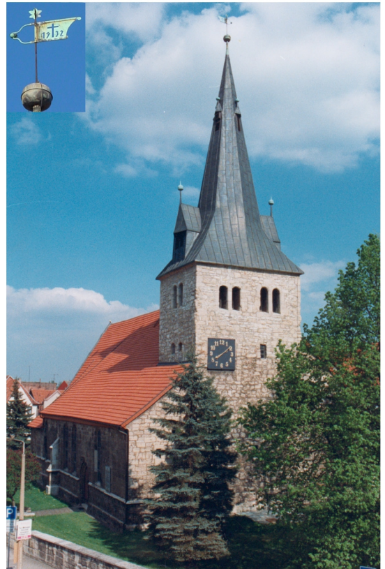
Westansicht, Westturm 35 m hoch mit oktagonalem Turmdach, Foto vom Pfarramt Bleicherode
