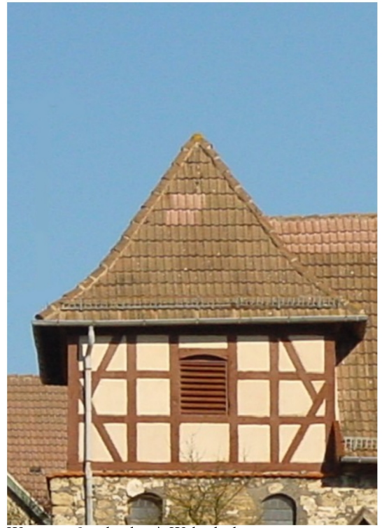
Westturm 9 m hoch mit Walmdach
