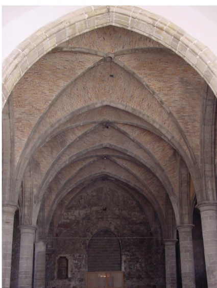
Gewölbe über Kirchenschiff
