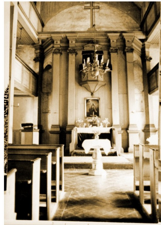
Innenansicht Richtung Chor 1970, Foto vom TLD Erfurt
