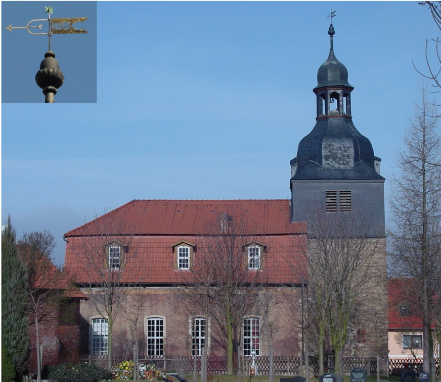
Kirchenansicht von Südosten
