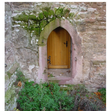
Gotisches Portal im Turm
