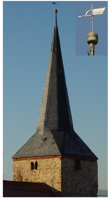
Westturm 25 m hoch mit oktog. Turmdach
