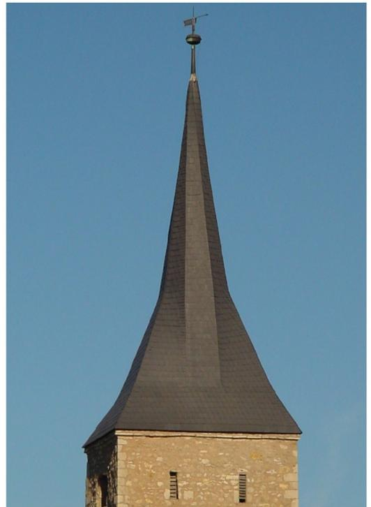
Ostturm 23 m hoch mit oktagonalem, oben schraubenförmig verdrehten Turmdach
