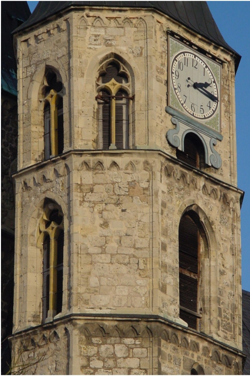
Südturmoberteil mit Turmuhr und Spitzbogenfries
