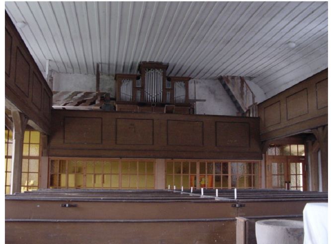
Innenansicht in Richtung Kirchenschiff
