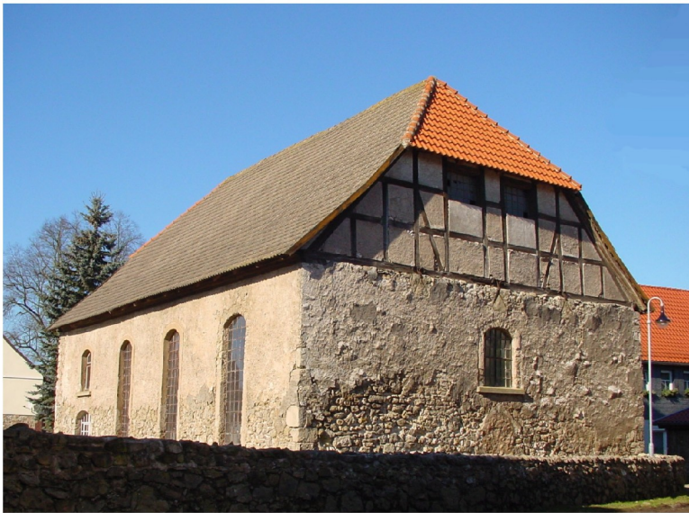
Kirchenansicht von Südosten
